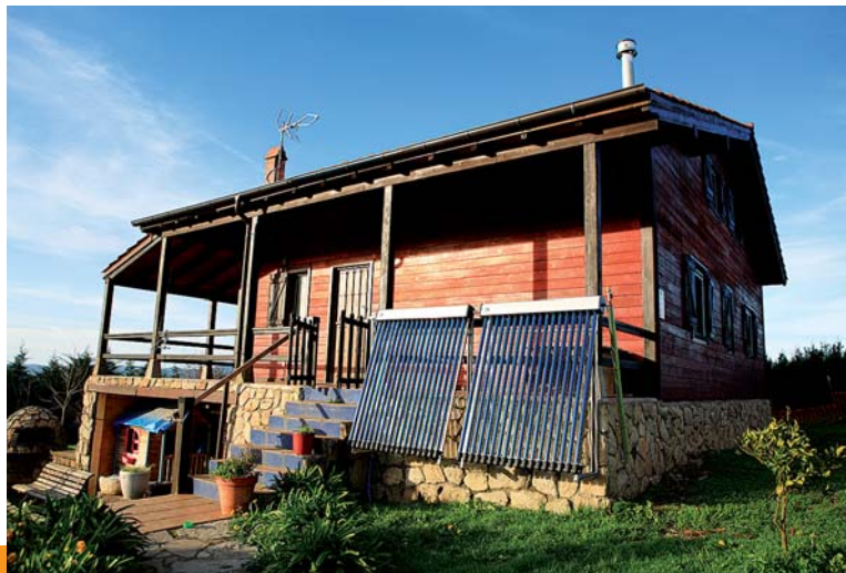
CASA BIOCLIMÁTICA EN EL BARRIO GANBE DE MORGIA (BIZKAIA). BIOMASA Y TUBOS DE VACÍO CONFORMAN SU SISTEMA DE APROVECHAMIENTO ENERGÉTICO.
