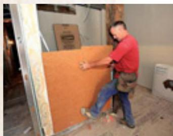
▲ REHABILITACIÓN DE UNA VIVIENDA EN EL CASCO ANTIGUO DE LEZO (GIPUZKOA). SE EMPLEAN COMO AISLANTE PLANCHAS DE CELULOSA. LAS TUBERÍAS SON DE POLIETILENO RETICULADO Y POLIPROPILENO.
